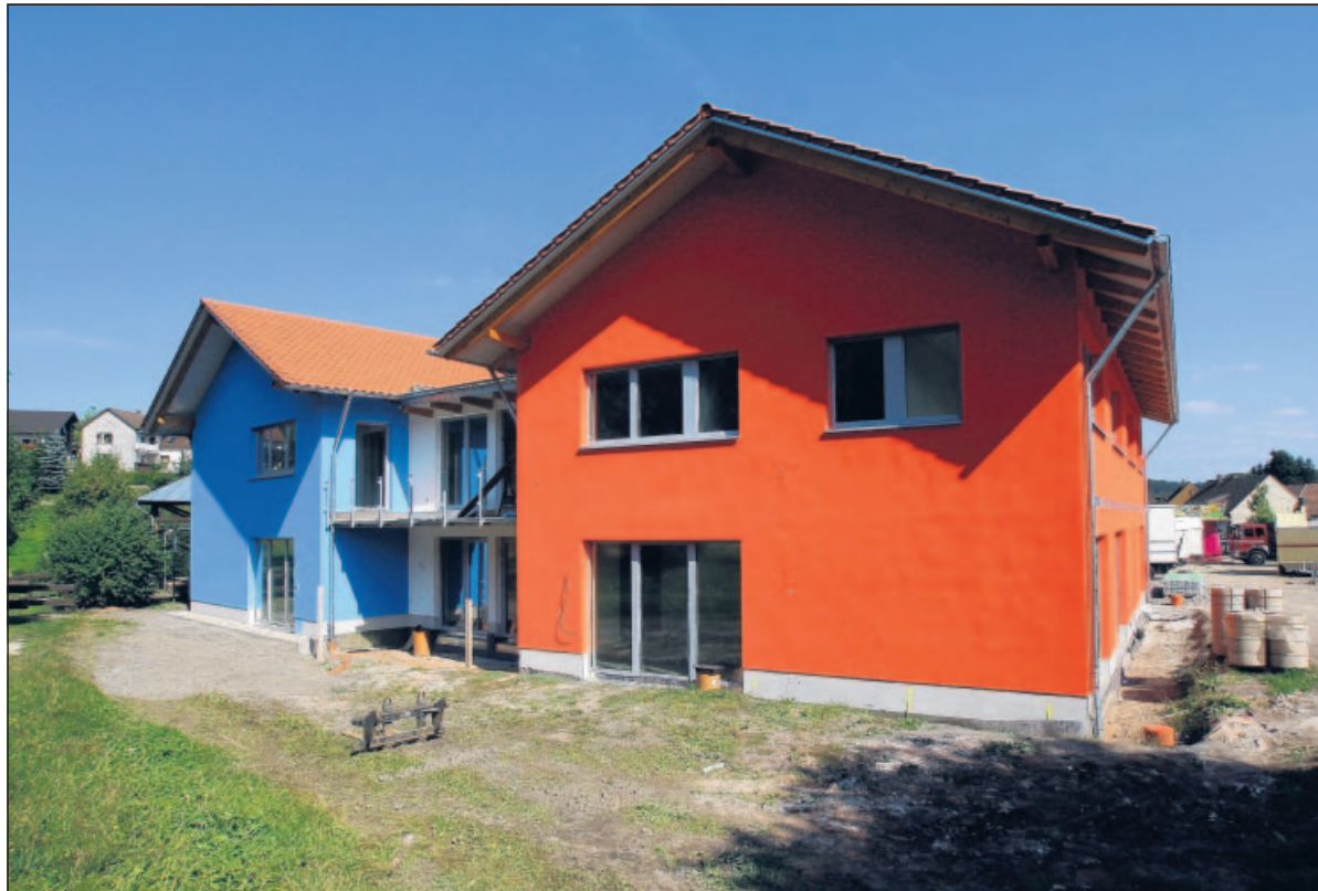
Großzügig dimensioniert, barrierefrei und hell, so präsentiert sich mittlerweile das zweieinhalb Millionen Euro teure Alois-Hemmer-Haus. Einziehen wird im nächsten Monat die Sozialstation. FOTO: SAYER
